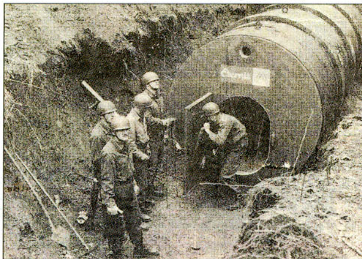
Die Bunker boten einen sicheren Unterschlupf. Hier sind Soldaten beim mühevollen Einbau eines solchen Fertigteils zu sehen.
