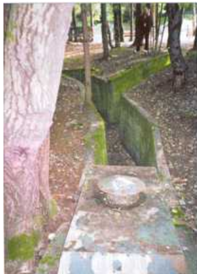
Posamezni deli utrdbе so povezani z odprtimi in pokritimi betonskimi rovi. (foto A.J.P.).
