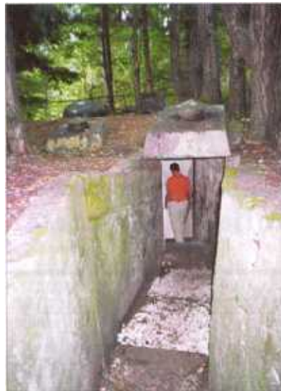
Posamezni deli utrdbе so povezani z odprtimi in pokritimi betonskimi rovi. (foto A.J.P.).
