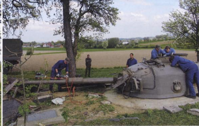
Demontage-Arbeiten des Bundesheers bei Steinkirchen* Unter der Tarnhütte auf einem Bauernhof steckte jahrzehntlang eine Panzerabwehrkanone, darunter ein unterirdischer Bunker, gesichert durch knapp zwei Meter Stahlbeton * Bezirk Scheibbs (Montag vergangener Woche)
